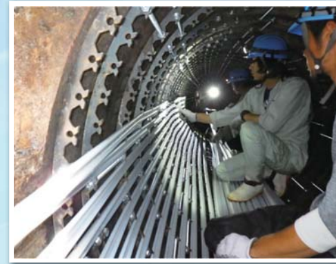
▲パルテムフローリング工法
