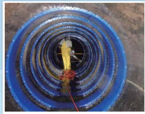
▲3Sセグメント工法
